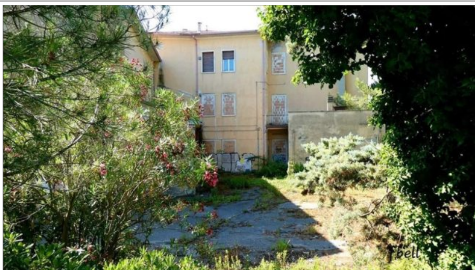
Una parte dell'ex complesso Pie Venerini a Posatora vista dal parco interno
