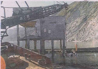
L'intervento di demolizione all'ex pesca Fattorini al Trave
