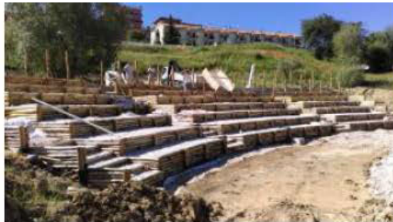
Lavori in corso per il nuovo teatro all'aperto di Agugliano
