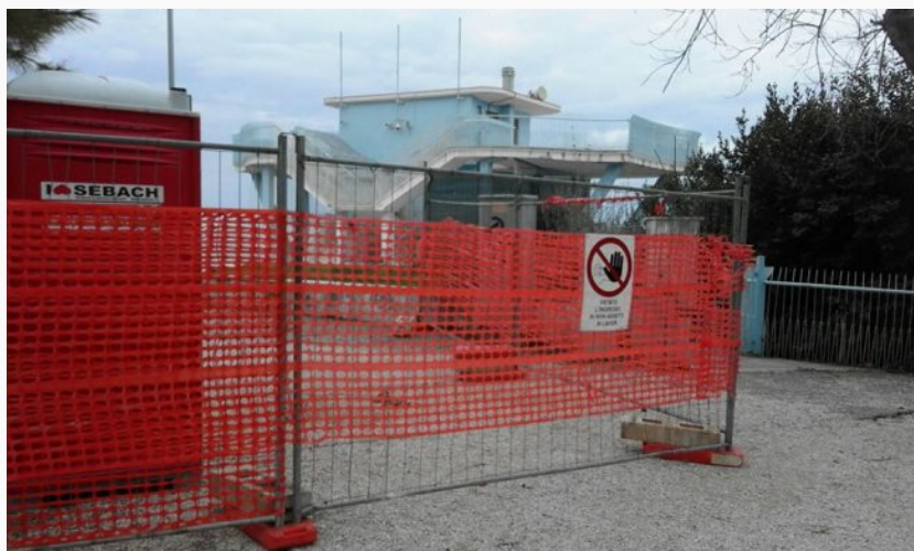
Il cantiere allestito venerdì all'ascensore
